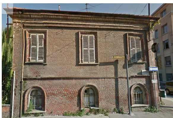
Facciata laterale del gazometro (da streetview di Googlemaps)
